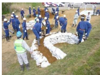
水防工法訓練
