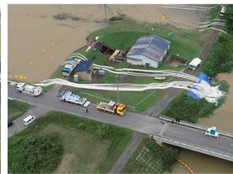
緊急災害対策派遣隊(TEC-FORCE)活動状況
