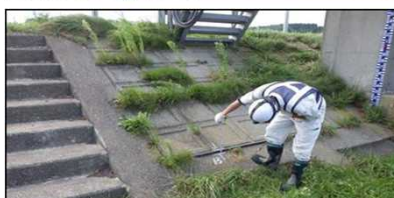
樋門樋管の点検
