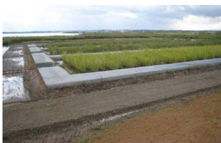
植生浄化施設
