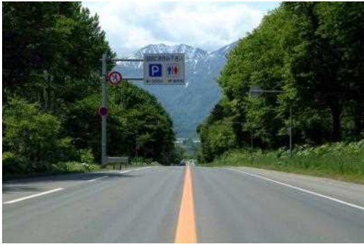
道路標識改善前(富良野市)
