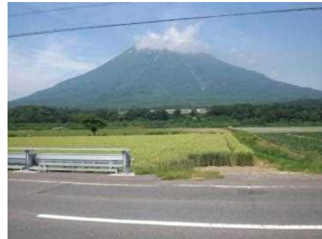
防雪柵更新後(京極町)
