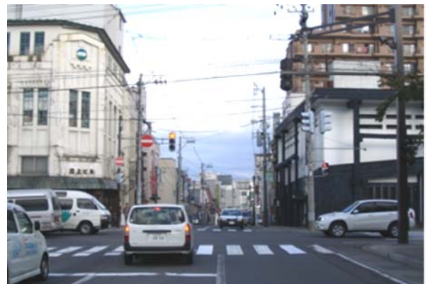
【県道弘前岳鱒ヶ沢線 整備中工区】
