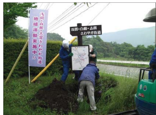
建て込み作業
