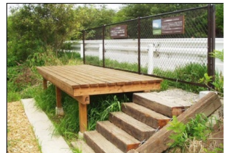
展望デッキ完成
