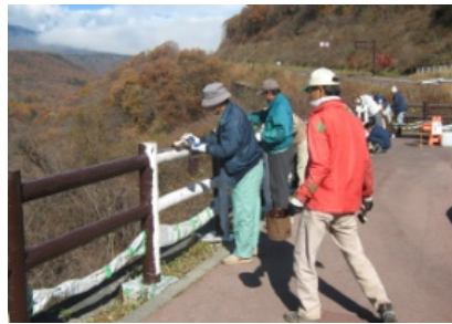
防護柵塗り替え中
