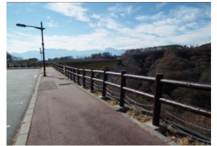
防護柵塗り替え後
