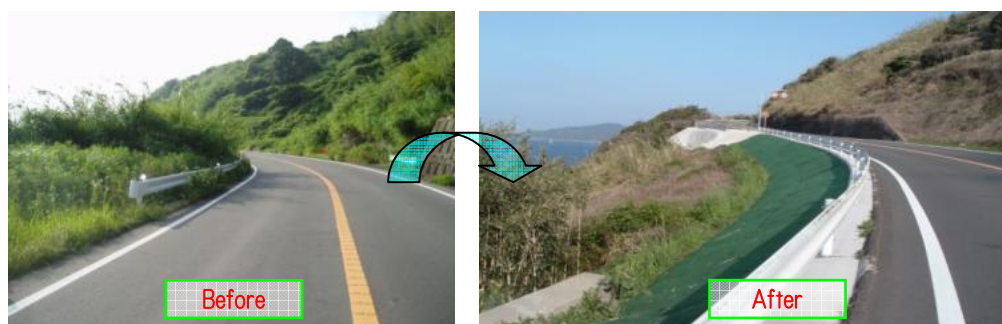
防草シートの施工事例(長崎県西海市大瀬戸町)
