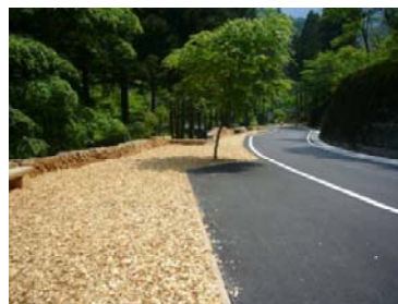
駐車と回遊スペースの状況
