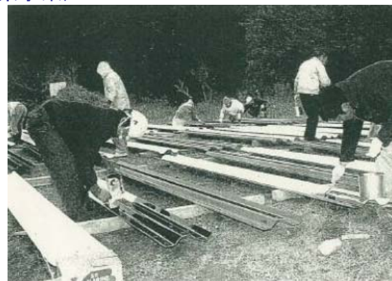
ペンキ塗りをする関係者 紀南新聞 平成20年2月15日 掲載より
