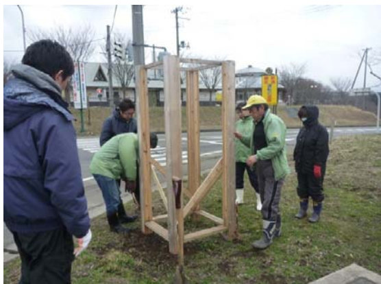
立体花壇の基礎となる柱の設置
