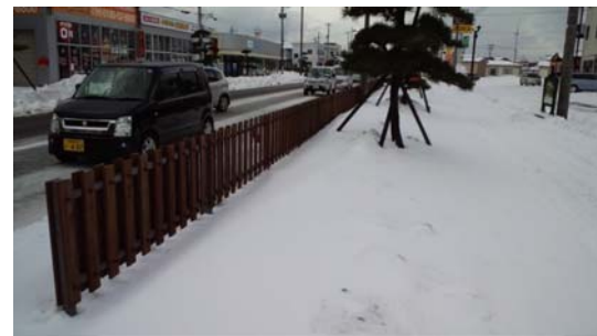
木製柵設置状況
