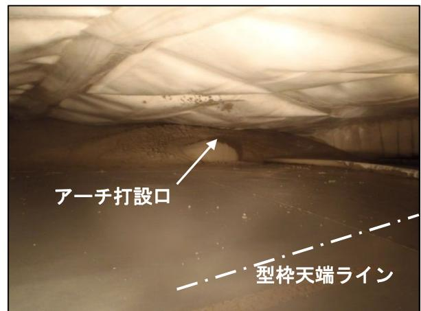
写真 6-2 アーチ打設口からの打込み（開始直後）
