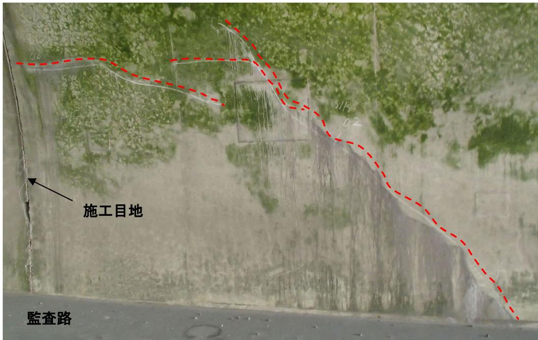
写真 1-10 側壁に発生したひび割れ
