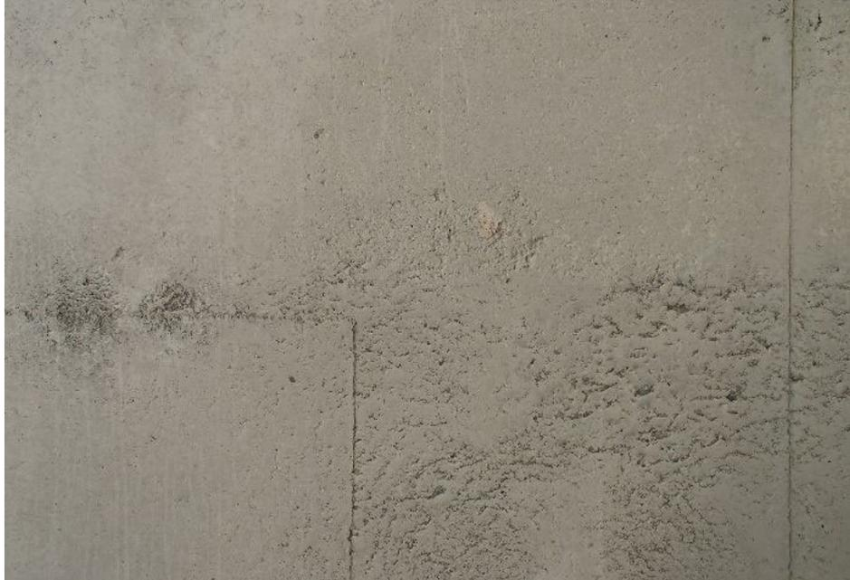
写真 1-13 検査窓周辺の水はしり・砂すじ
