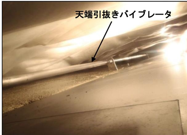
写真 6-5 アーチ打設口からの打込み (完了)
