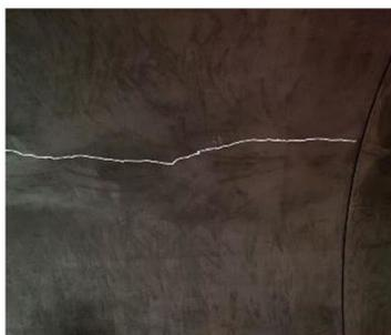
⑦天端部の縦断方向ひび割れ
