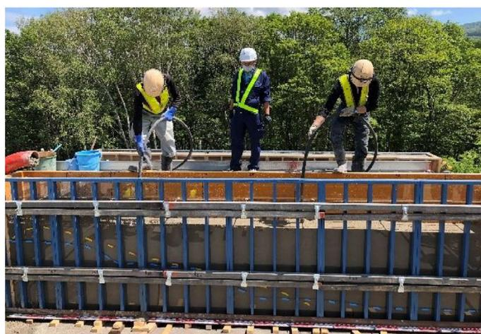
写真 6-13 2 層目、締固め間隔管理
