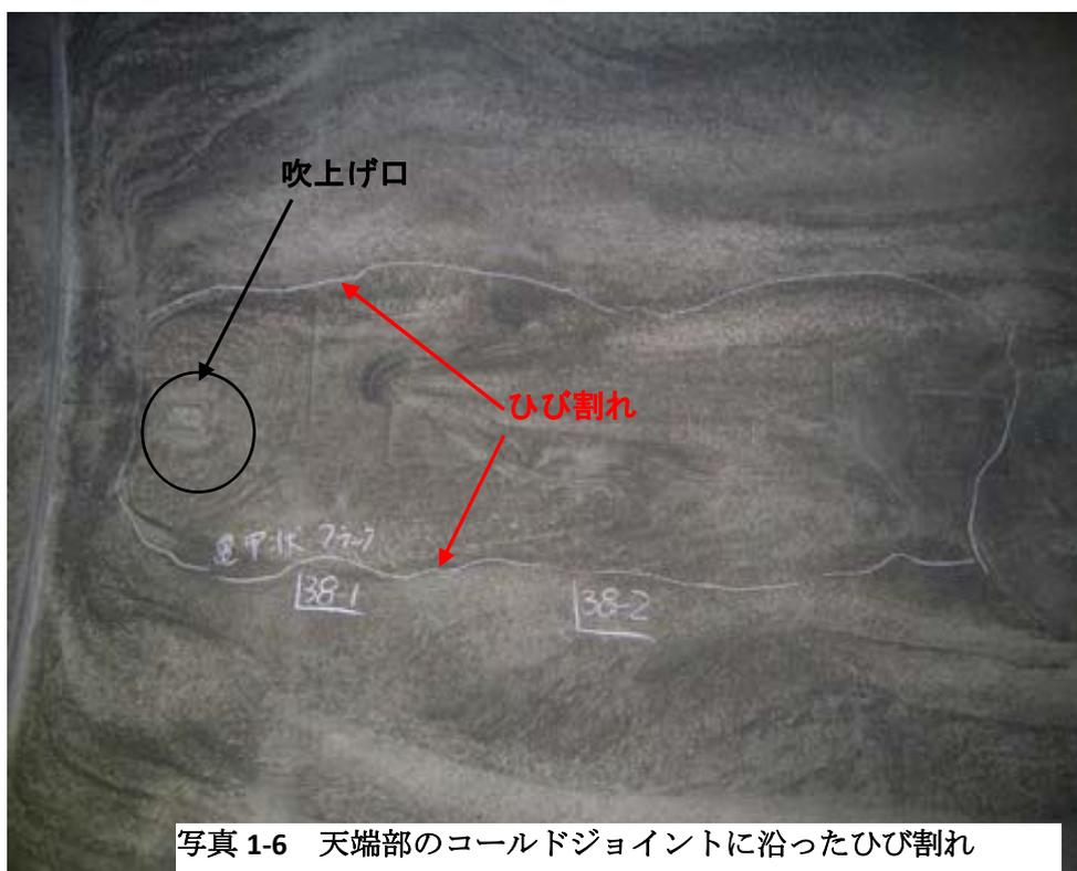
写真 1-6 天端部のコールドジョイントに沿ったひび割れ
