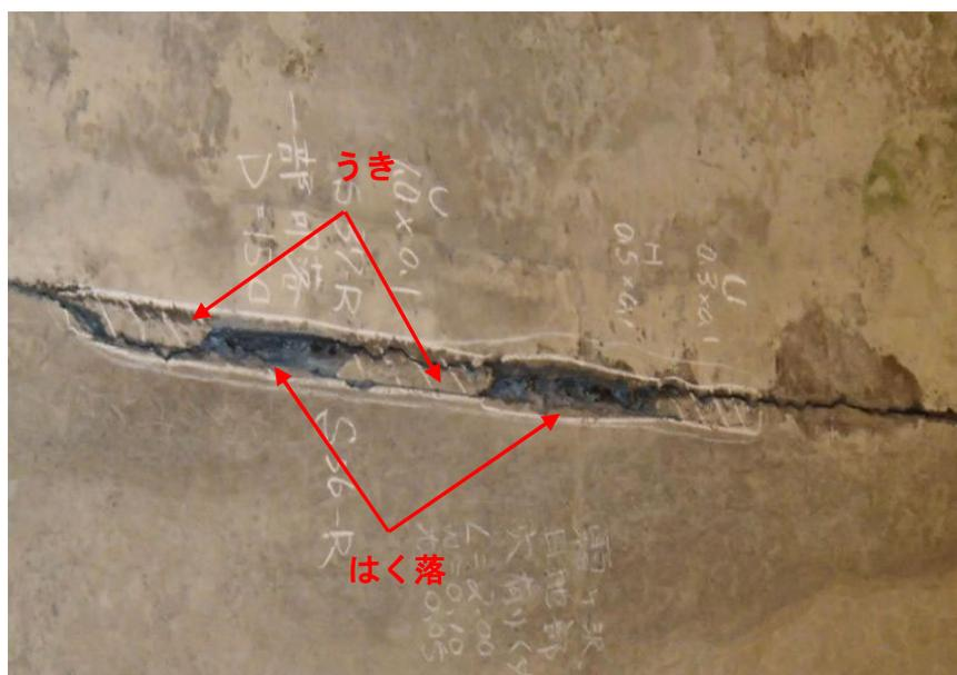
写真 1-2 施工目地 (天端部) のうき・はく落
