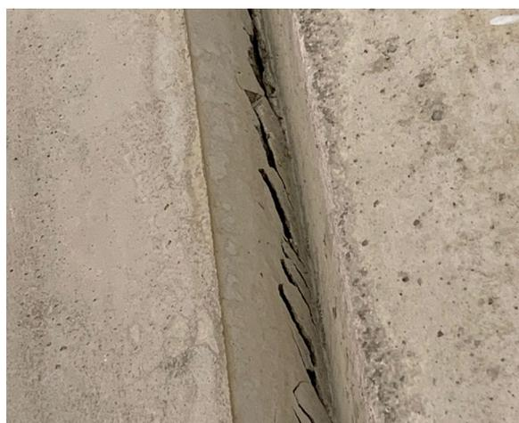
写真 1-17 コンクリートの収縮による開きで生じたと思われる目地部でのひび割れ
