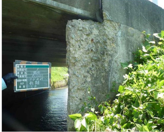
写真1-⑥ 凍害の事例（岩手県奥州市）
