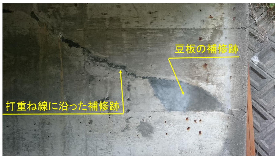
写真1-12 不具合がなければ不要だった補修の事例
