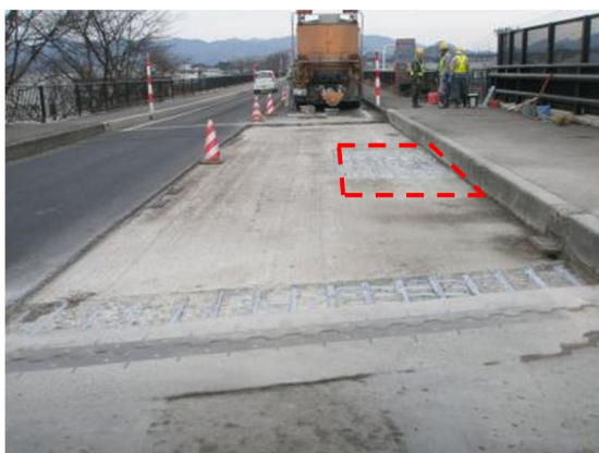
上り線橋面舗装工事の状況
