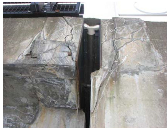
写真1-⑨ 桁端部だけに発生したひび割れ
