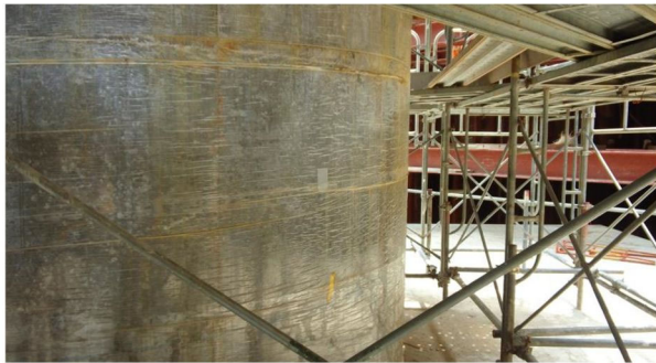
100m巻2000円の農業用ビニールシートで橋脚を長期養生
