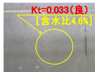
木製型枠部分
