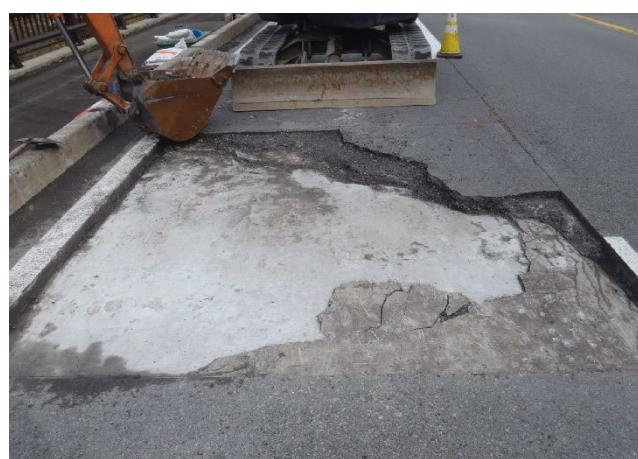
写真12-② 調整モルタルの割れ
