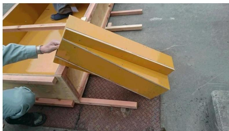
写真6-2-⑤ 型枠でつくった模擬排水枠
