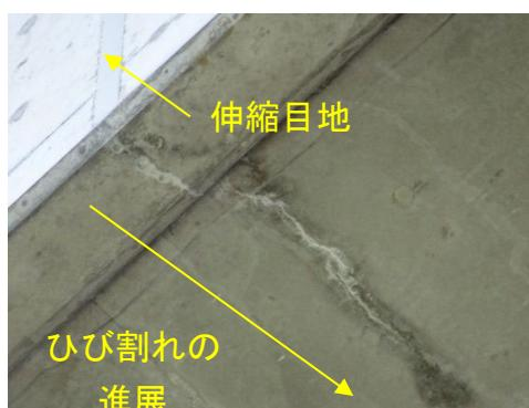
写真5-② 壁高欄の目地部からR C床版下面に進展したひび割れの事例（下面）
