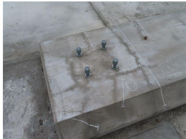
写真5-⑤ 中央分離帯の基礎コンクリートのひび割れ
