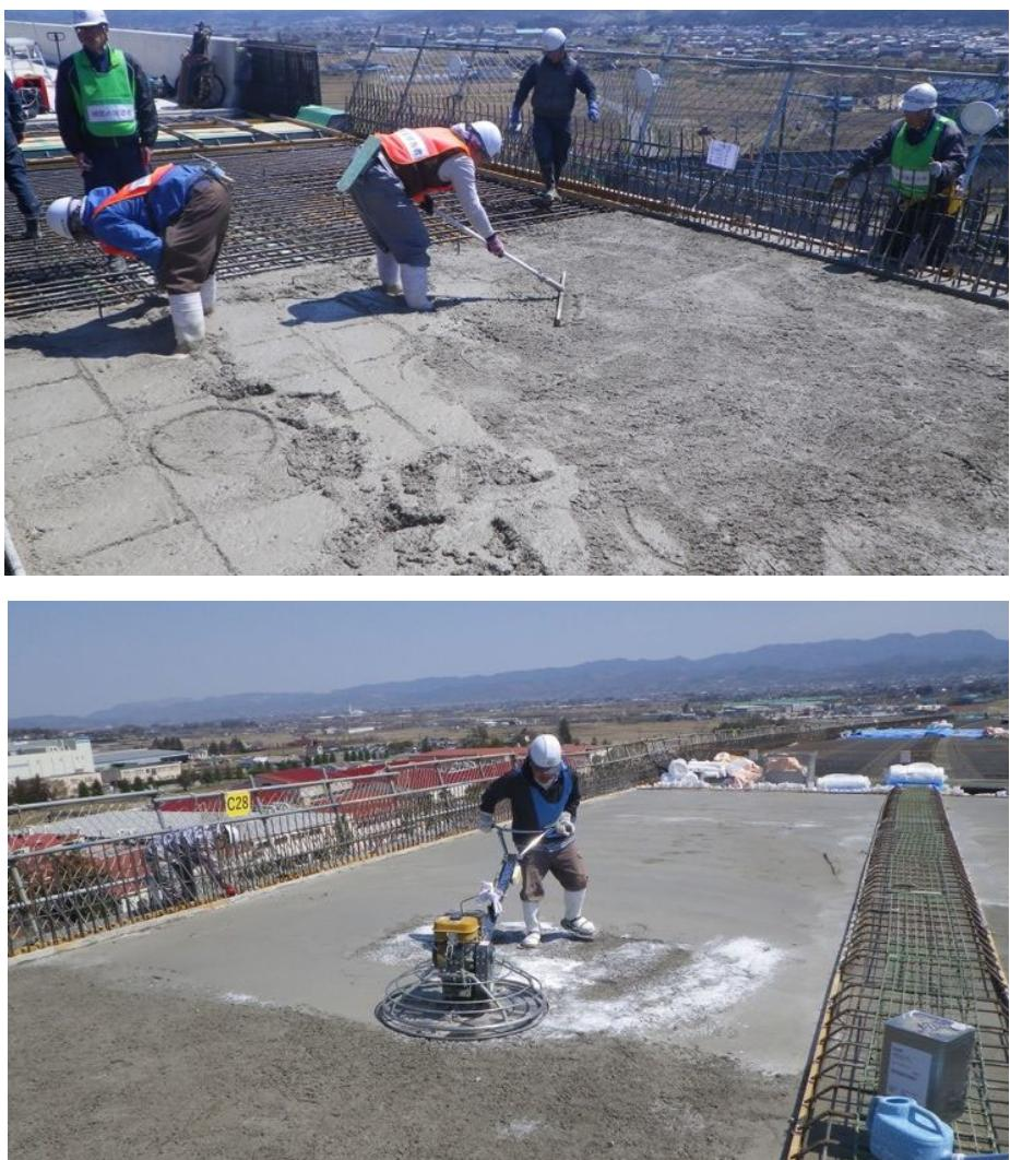
図3-⑤ 単位水量約  $160\text{kg/m}^3$  のコンクリートの仕上げ状況
