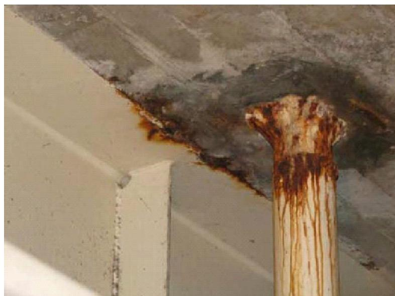
写真6-2-④ 床版の排水管周りからの漏水事例
