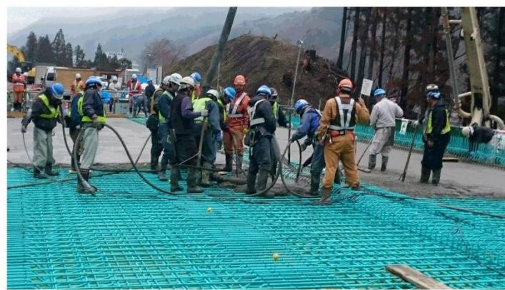
締固めと空気量の確保を両立するため締固め時間は8秒を目安
