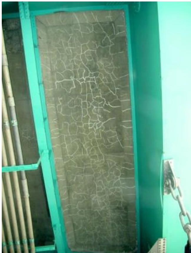
写真1-① RC床版の二方向ひび割れの事例
