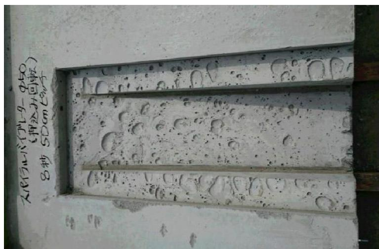
写真6－2－⑧ スパイラルバイブルータによる排水枠下の状況
