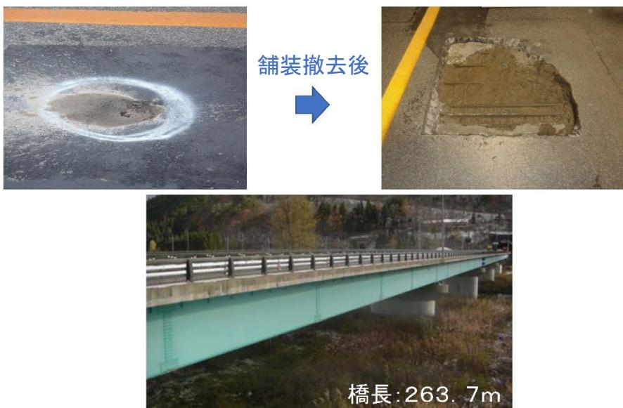
写真1-⑫ 床版の土砂化により緊急打換えを実施した橋梁
