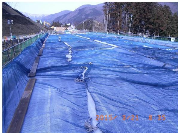
写真7-⑬ 床版上面の養生状況
