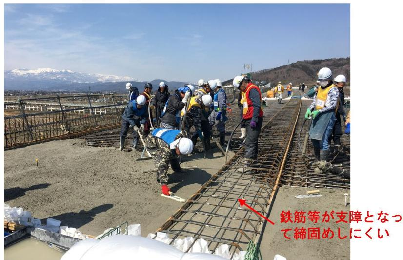
写真 7-③② 中央分離帯がある場合の床版の施工状況
