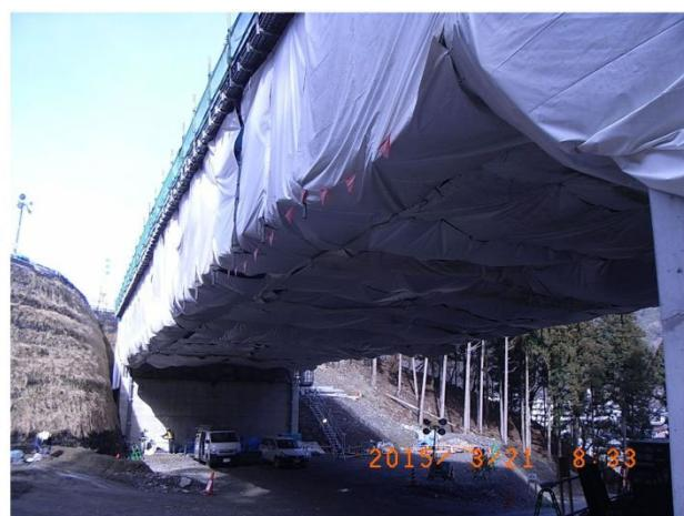
写真 7-⑫ 桁下の養生状況
