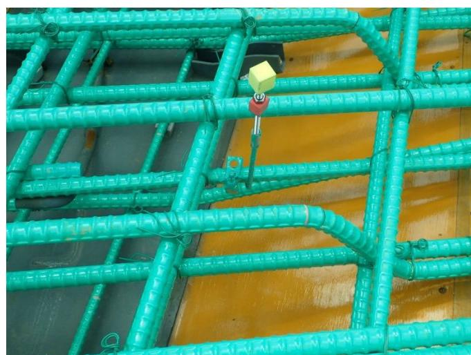
写真 7-⑰ 天端表示金具を樹脂被覆した例
