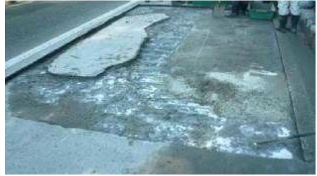
床版上面コンクリートの劣化部を撤去した状態
