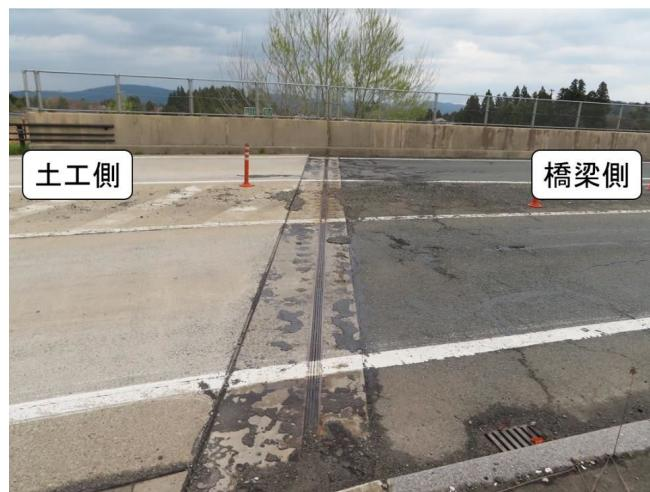
写真1-⑪ 舗装の施工ジョイントから水が浸入し土砂化が発生した事例
