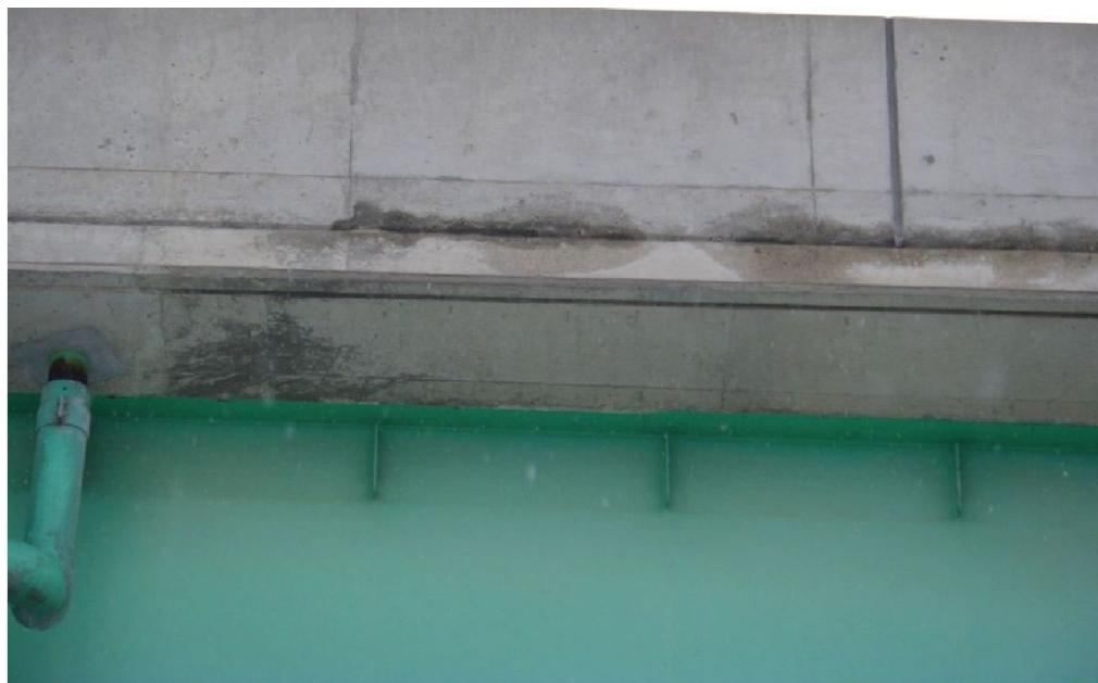
写真 6-1-⑫ 地覆打継ぎ目部からの漏水
