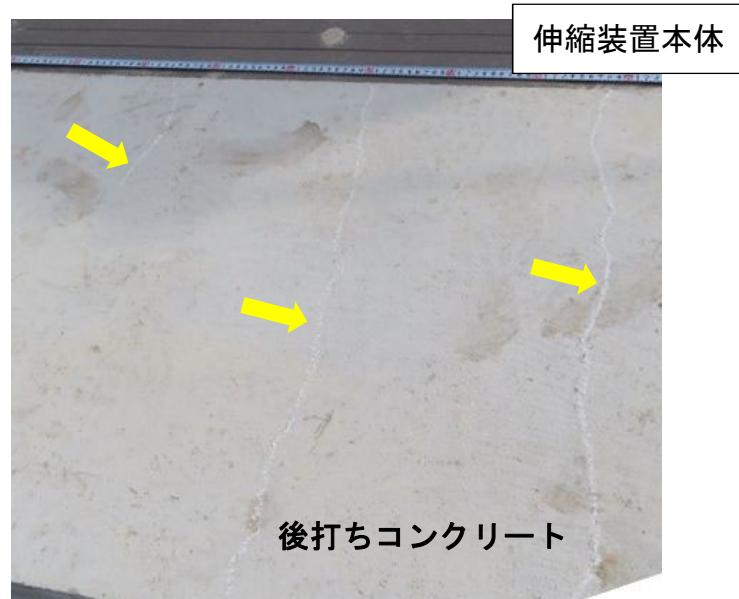
写真5-③ 伸縮装置の後打ちコンクリートのひび割れ
