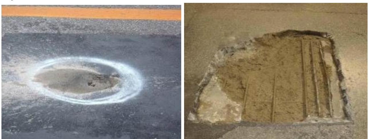
写真1-③ RC床版の土砂化の事例
