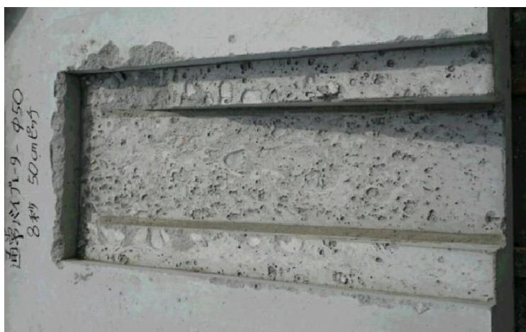
写真6－2－⑦ 通常バイブルータによる排水枠下の状況
