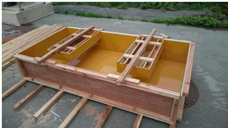
写真6－2－⑥ 模擬床版に模擬排水枠をセットしたところ
