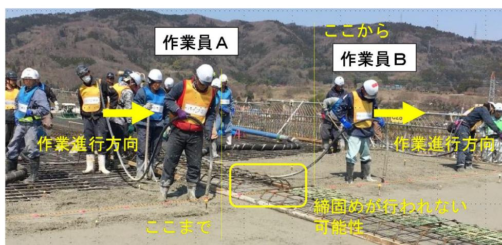
写真 7-③③ 中央分離帯がある場合の床版の締固め状況（その 1）
