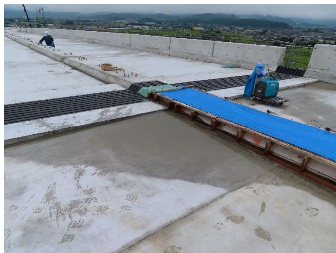
写真5-⑥ 伸縮装置の後打ちコンクリートと中央分離帯の基礎コンクリートが接している場合の滯水事例
