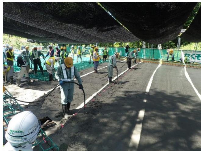
写真 7-㉑ 遮光ネットによる日除け設置例
