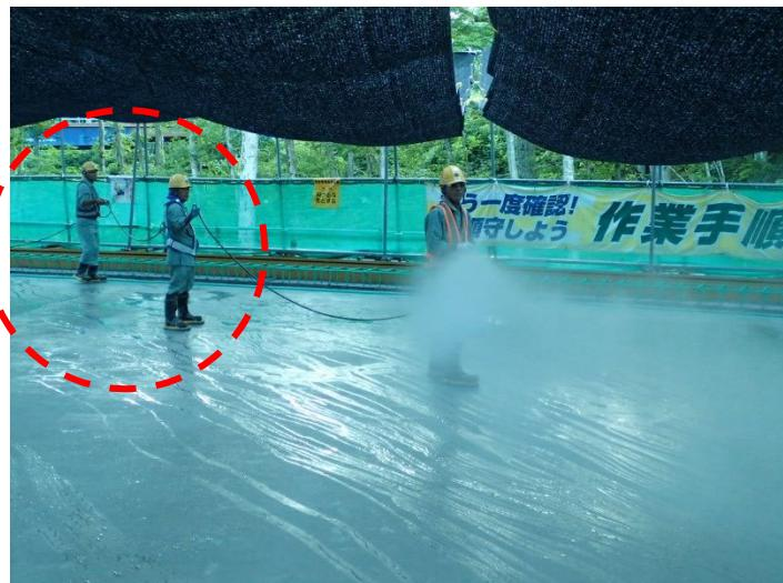
写真 7-29 養生シート敷設前の散水状況
