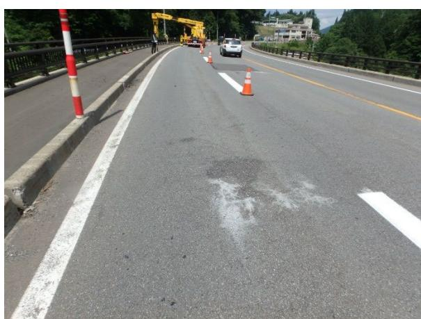
写真12-① 舗装上面の析出物
