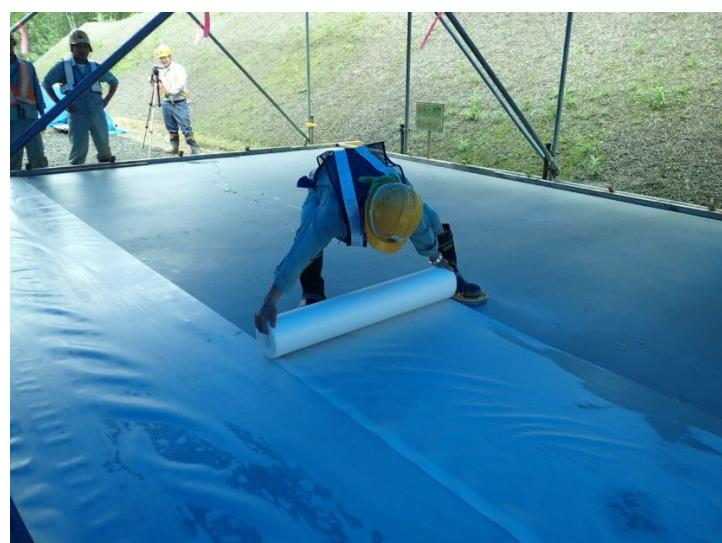
写真 6－2－⑱ 濡潤養生マットの適用性を確認
