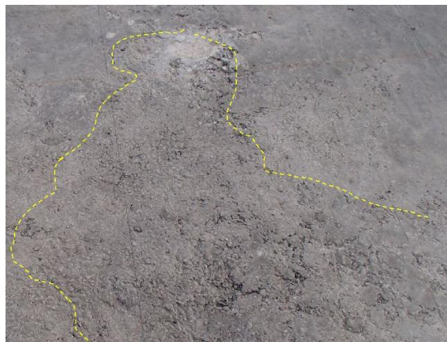
写真6-1-③ 床版上面の充填不良
