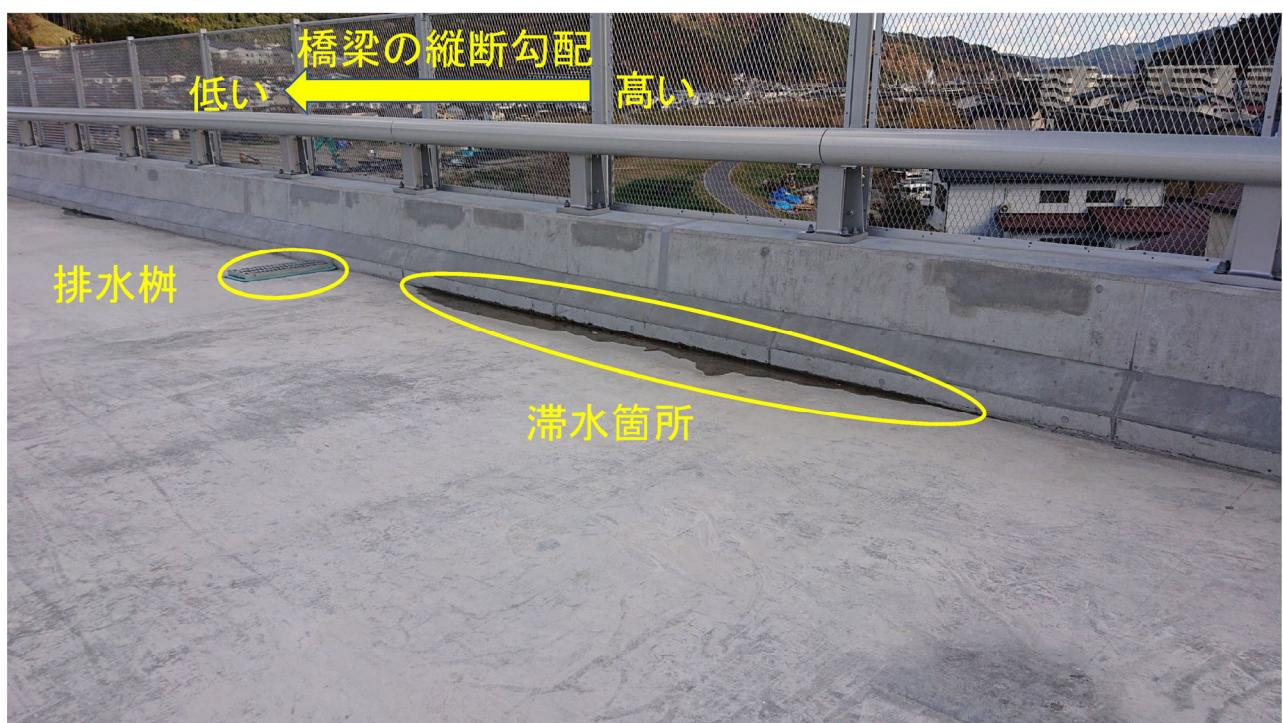
写真6-1-⑦ 床版上面に生じた平坦性不良による滯水
