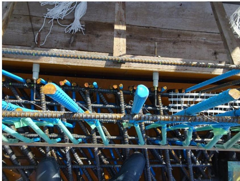
写真 7-① エポキシ樹脂塗装鉄筋の切断部の塗膜損傷
