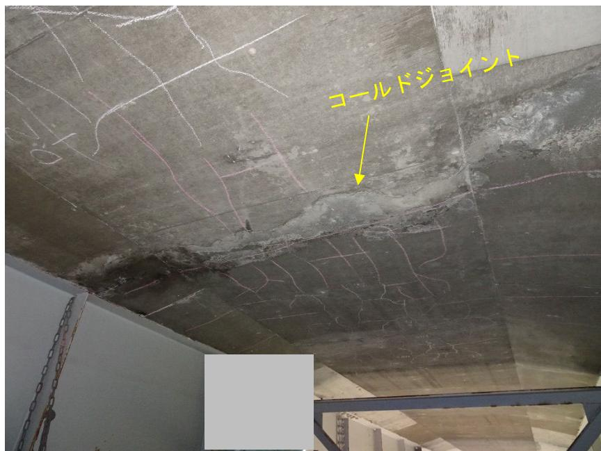
写真6-1-⑥ 床版打重ね部に沿ったコールドジョイントの例
