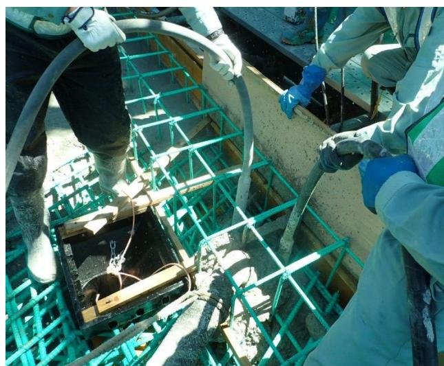
写真 7-㉓ 養生板を用いた打込み時の飛散対策例
