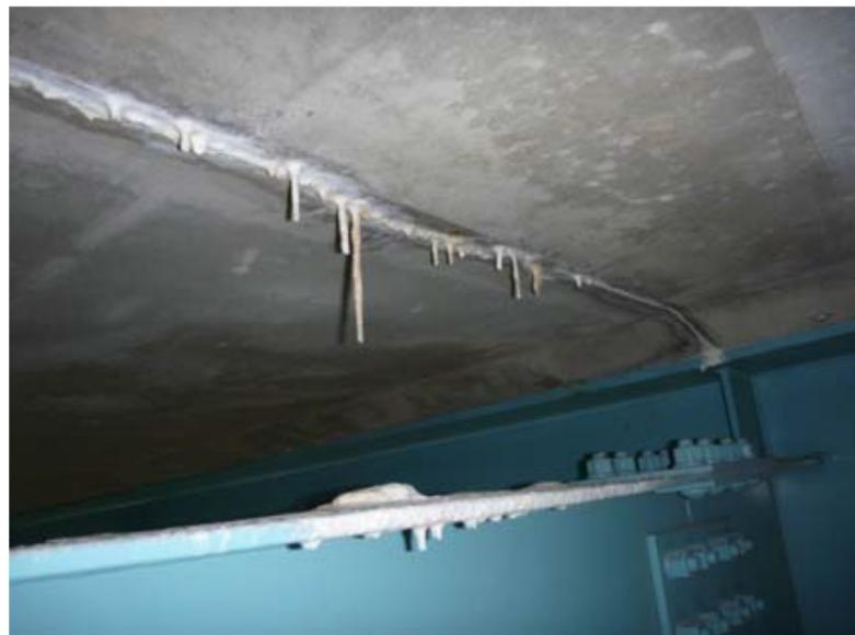
写真6-1-⑩ 施工ジョイントから生じた床版下面の漏水
