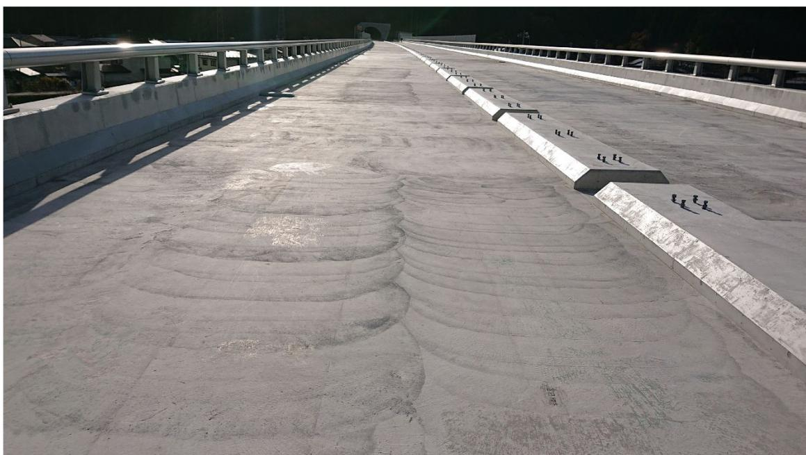
写真6-1-⑨ 床版上面に生じた仕上げ不良
