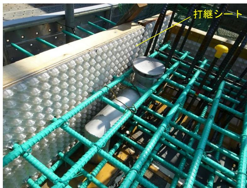
写真6-1-⑪ 打継目の処理（打継シート）の例
