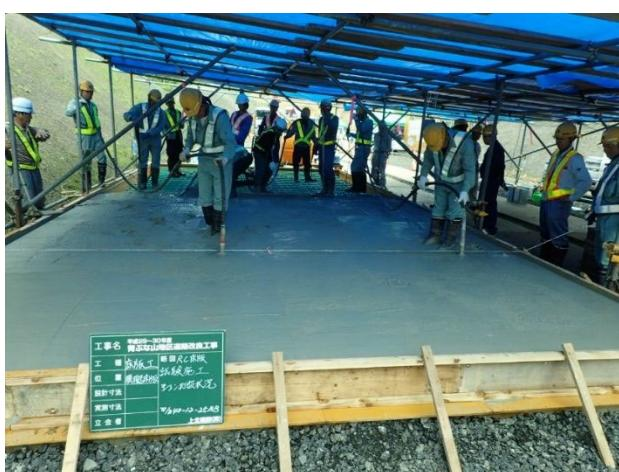
写真6-1-④ 50cm 間隔による締固め
