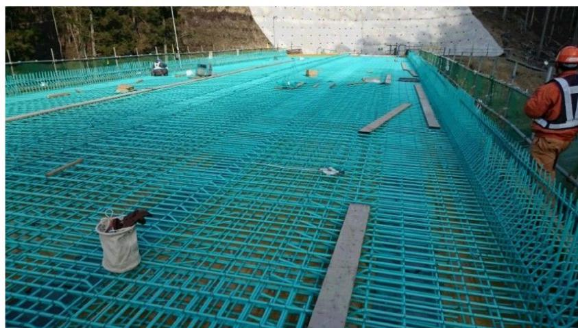
写真 7-③ エポキシ樹脂塗装鉄筋の採用例
