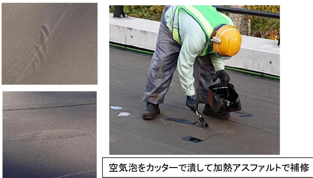
写真1-⑫ シート防水内の空気泡をつぶして補修
