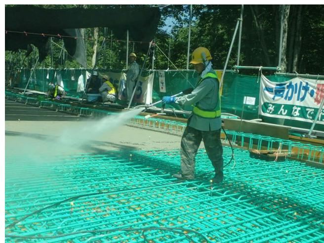
写真 7-⑮ 高圧洗浄機による打継ぎ面の散水（湿潤状態の確保）
