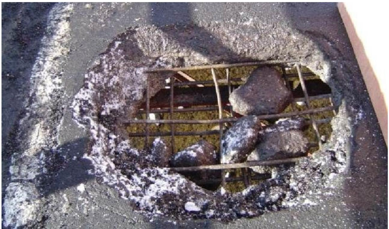
写真1-② RC床版の抜け落ちの事例（押抜きせん断破壊）
