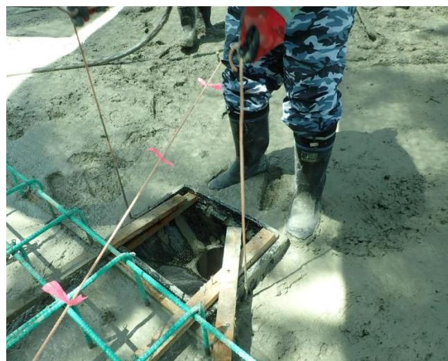
写真 7-⑭ 路面排水溝下面の気泡抜き例（紐による気泡抜き）
