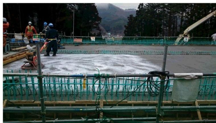
写真 7-⑪ 表面養生材の散布状況
