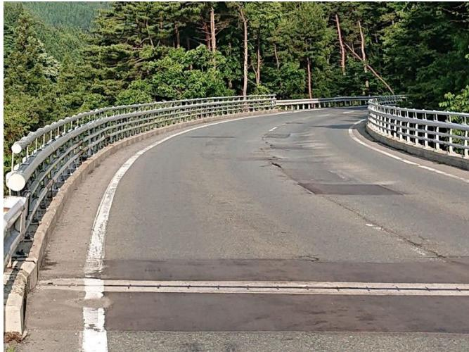
写真1-⑥ タイヤの走行軌跡に沿った舗装の補修跡と土砂の噴出状況
