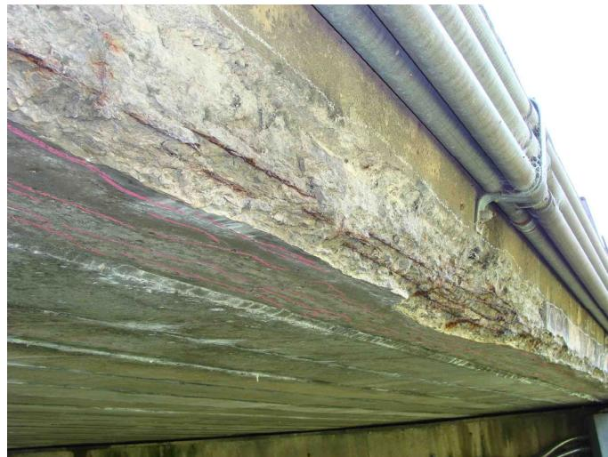
写真1-⑯ コンクリート橋の外桁下部に凍害を含む劣化が生じた事例
