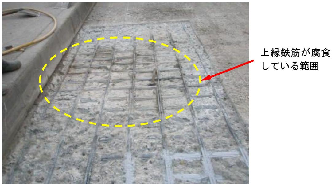
写真 1-19 塩害等による上縁鉄筋の腐食事例 (秋田県 国道 7 号)
