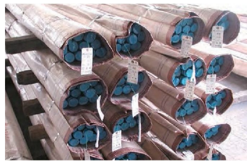
写真-資 3.3 吊上げ及び仮置き事例
