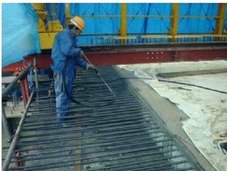
写真-解 7.2 高圧水によるレイタンス処理状況
