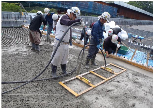
写真-解5.1 内部振動機の挿入間隔の管理事例
