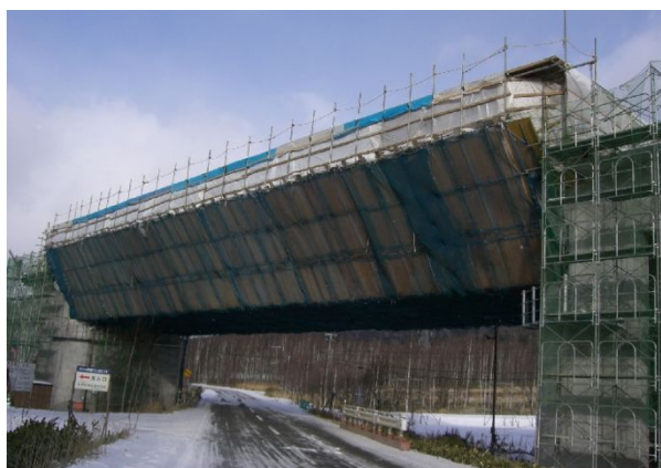
写真-解 6.4 厳冬及び積雪地方での寒中養生の例
