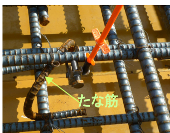
写真-解 6.1 たな筋による沈下防止
