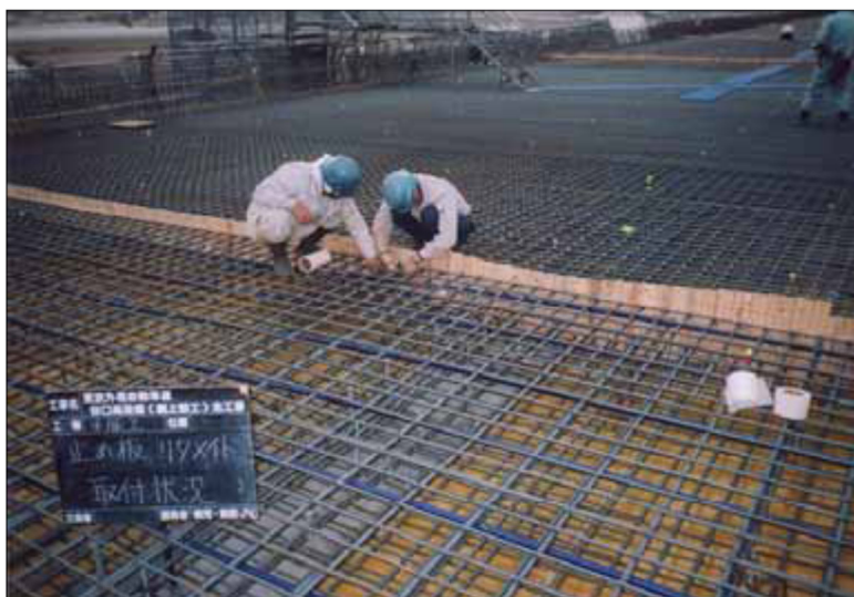
写真-解 7.1 せき板設置・凝結遅延剤塗布状況
