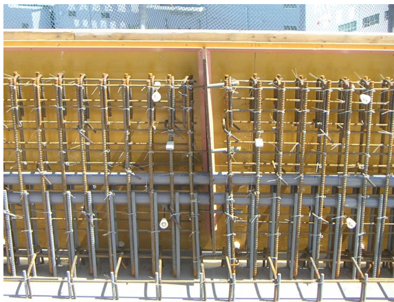
伸縮目地挿入状況
