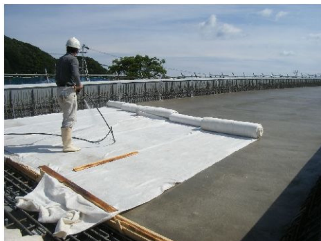
写真-解 6.2 養生マット施工状況
