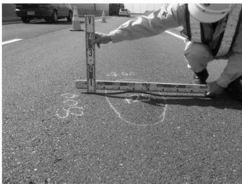
写真-解 8.3 床版上面の滞水による劣化
