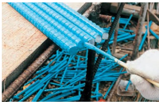
写真-資 3.6 補修塗装状況
