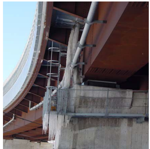
写真-解 8.7 配水管凍結による破損例
