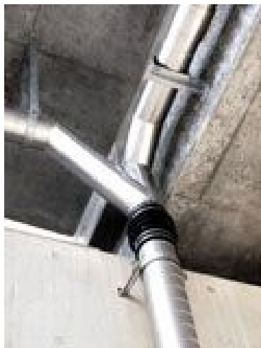
写真-解 8.6 高気密性ステンレス排水管 (排水バンドと配水管の接触面で異種金属間腐食が生じる場合があるので、ゴム板を間に挟んで絶縁する必要がある)
