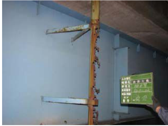
写真-解 8.5 排水管の腐食状況
