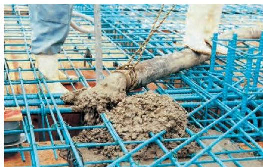
写真-資 3.5 コンクリート打込み状況
