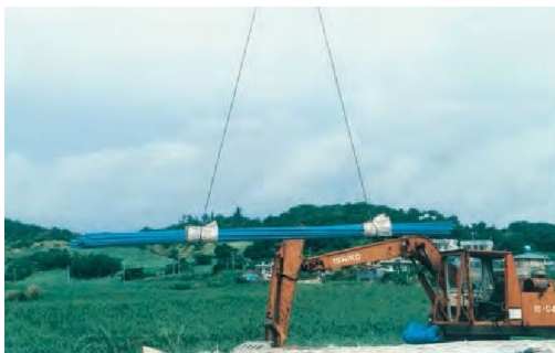
写真-資 3.3 吊上げ及び仮置き事例
