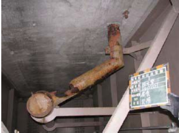
写真-解 8.5 排水管の腐食状況
