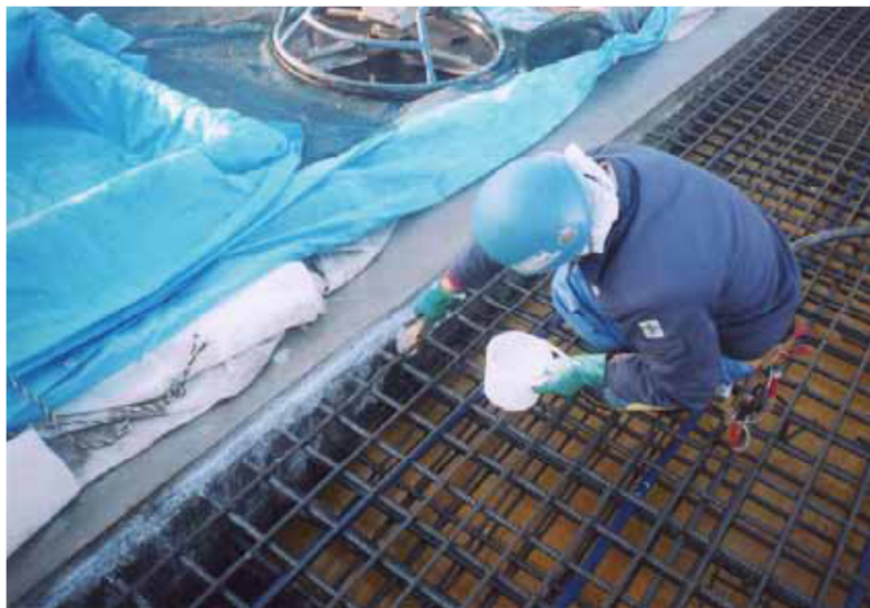
写真-解 7.4 打継目への接着剤塗布状況
