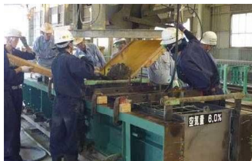
写真-1 新仕様 6.0%試験体の製作状況
