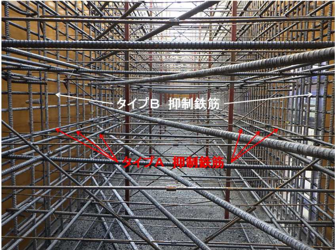
巻末写真-① A高架橋 A 2橋台 抑制鉄筋配置状況
