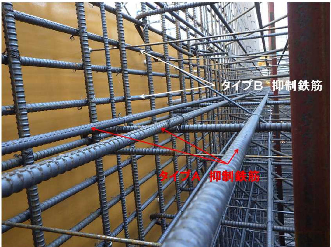
巻末写真-② A高架橋 A 2橋台 抑制鉄筋配置状況
