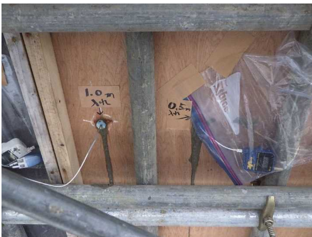
※温度計設置状況 (1.0m と 0.5m)
