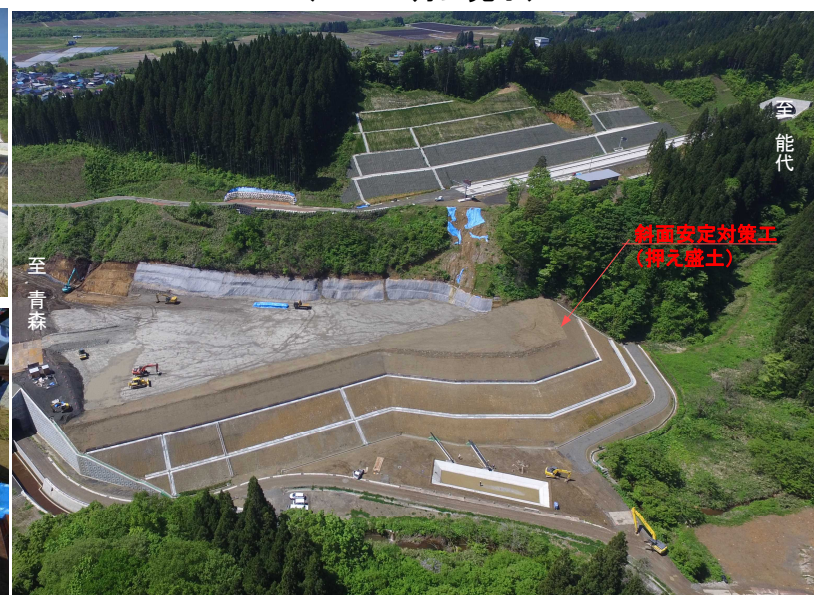
③斜面の安定対策工の状況(R6.6月に完了)
