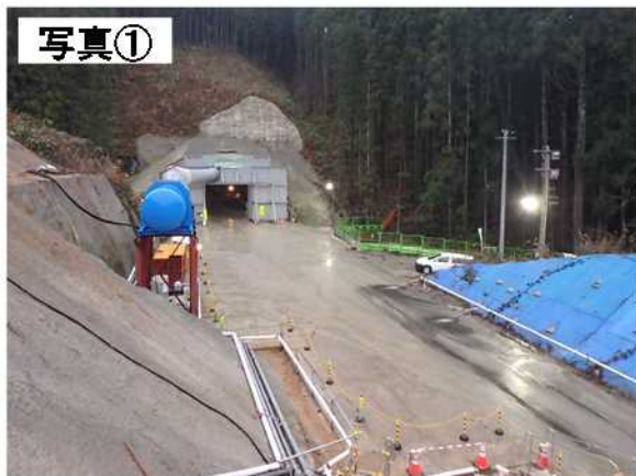
写真① ▲(仮称)小繫トンネルの施工状況(R1.12撮影)
