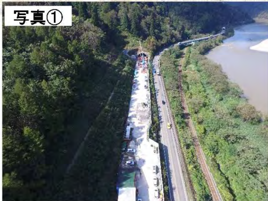
▲(仮)猪ノ鼻トンネルの施工状況(R1.11撮影)
