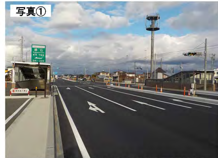
▲鏡石町役場入口交差点付近の開通状況(R2.1撮影)
