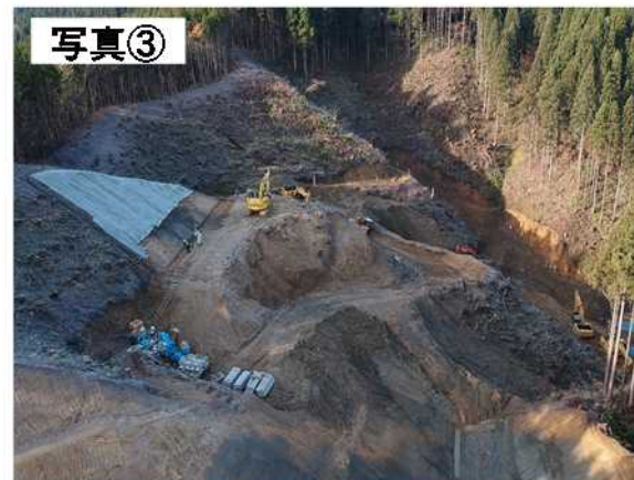
写真③ ▲道路改良工事の施工状況(R1.11撮影)
