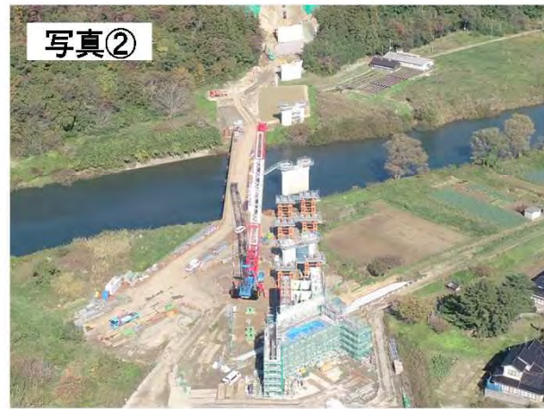
写真② ▲(仮称)日向川橋の施工状況(R1.11撮影)
