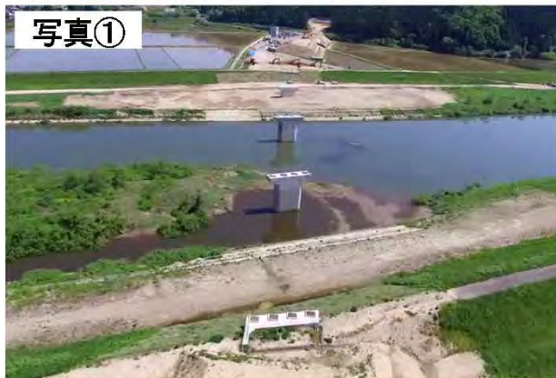
▲(仮)鮭川橋の施工状況(R1.11撮影)
