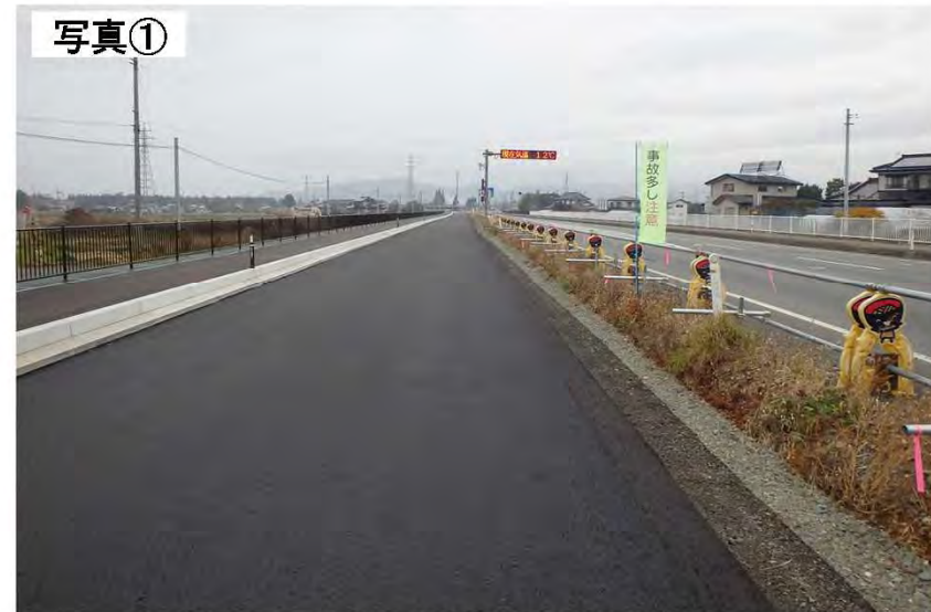
▲舗装工事の施工状況(地上より)(R1.12撮影)
