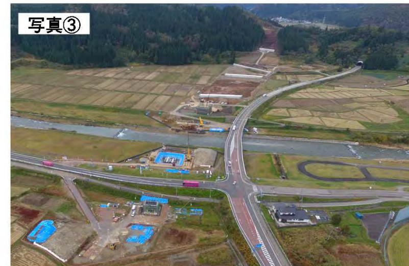
▲(仮称)役内川橋の施工状況(R1.10撮影)
