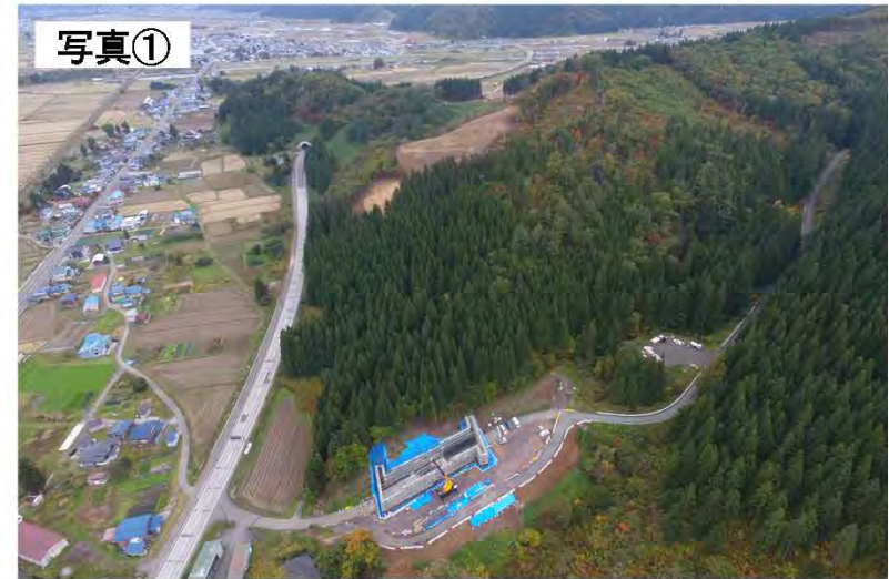
▲道路改良工事の施工状況(R1.10撮影)
