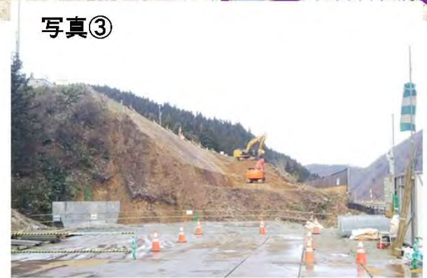
▲道路改良工事の施工状況(R1.11撮影)
