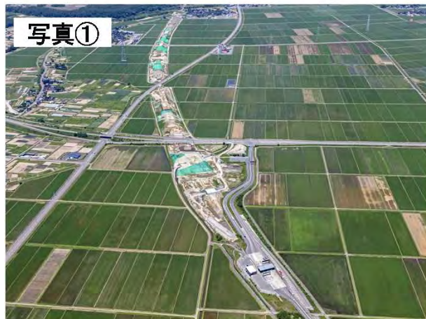
写真① ▲酒田みなとICの施工状況(R1.6撮影)
