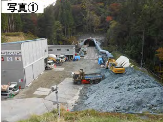
▲(仮)3号トンネルの施工状況(R1.11撮影)
