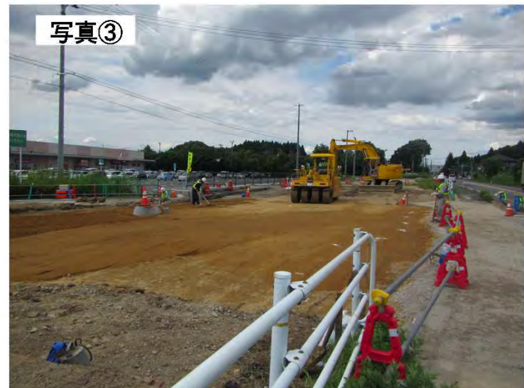
▲道路改良工事の施工状況(R1.7撮影)
