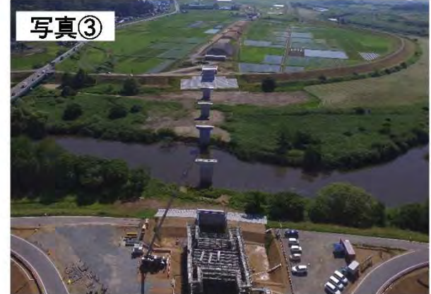
写真③ ▲(仮)新幸来橋の施工状況(R1.6撮影)
