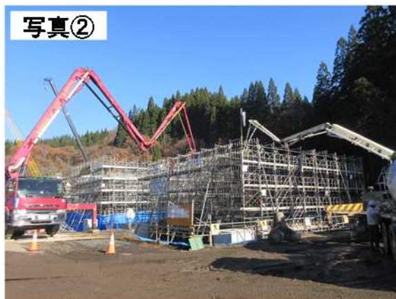
写真② ▲函渠の施工状況(R1.11撮影)
