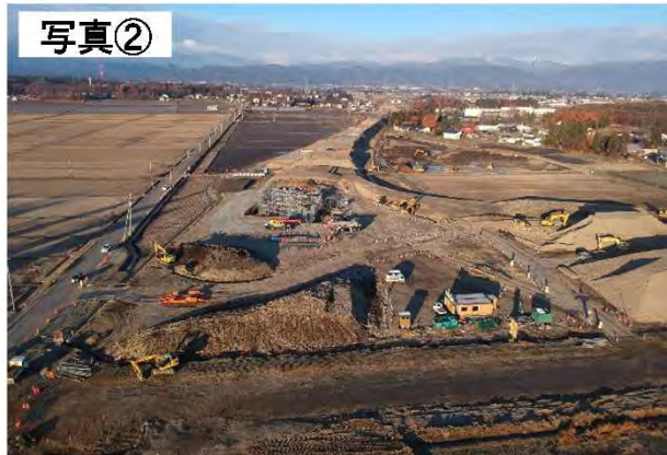
写真② ▲(仮)川西ICの施工状況(R1.11撮影)
