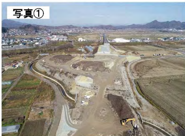
写真① ▲(仮)村山ICの施工状況(R1.11撮影)
