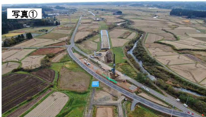
▲道路改良工事の施工状況(R1.11撮影)
