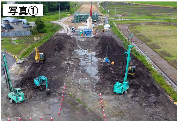
写真① ▲軟弱地盤対策工の施工状況(R1.7撮影)
