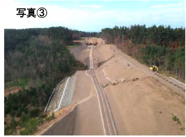
写真③ ▲道路改良工事の施工状況(R1.12撮影)
