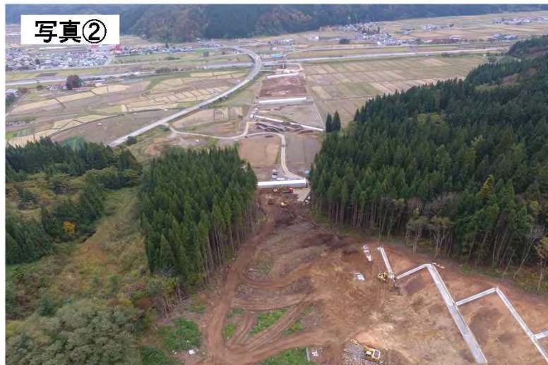
▲道路改良工事の施工状況(R1.10撮影)
