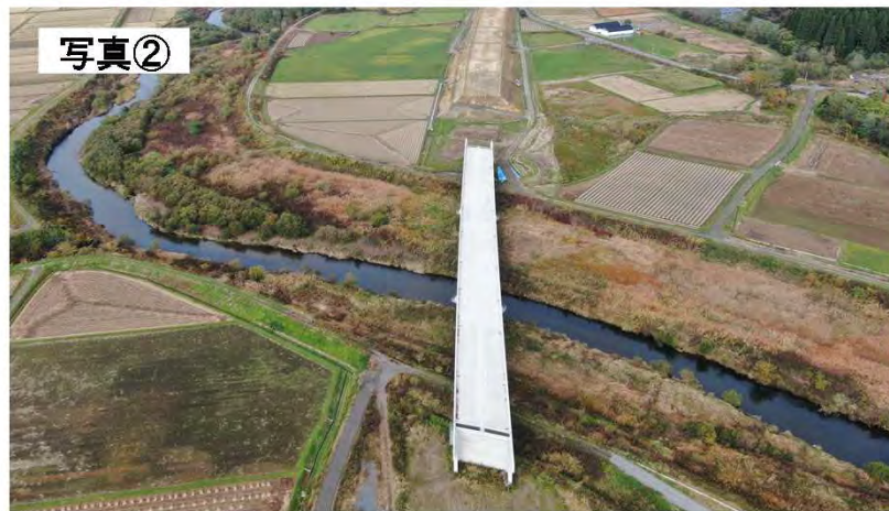
▲(仮)坪川橋の施工状況(R1.11撮影)
