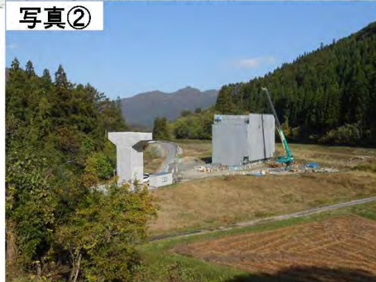
▲(仮)5号橋の施工状況(R1.11撮影)
