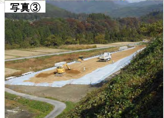
▲道路改良工事の施工状況(R1.11撮影)
