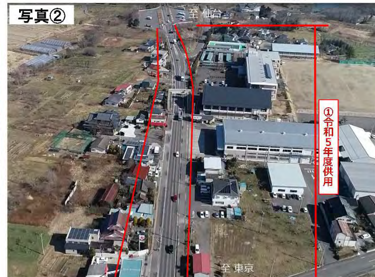
▲終点部の状況 (R1.4撮影)
