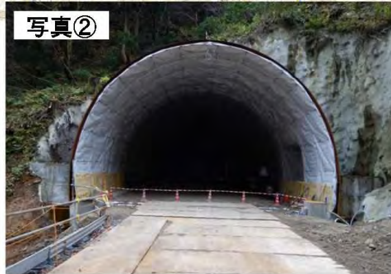
▲(仮)猪ノ鼻トンネルの施工状況(R1. 11撮影)
