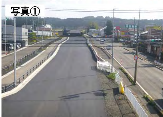
写真① ▲舗装工事の施工状況 (R1.11撮影)
