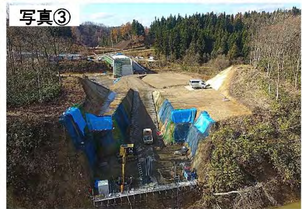
▲道路改良工事の施工状況(R1.12撮影)
