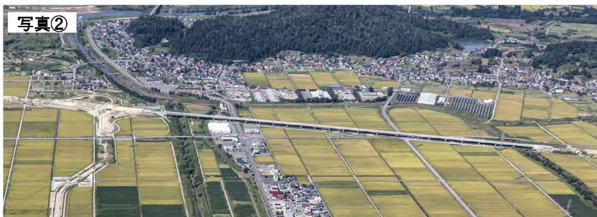
写真② ▲(仮)西郷高架橋の施工状況(R1.9撮影)
