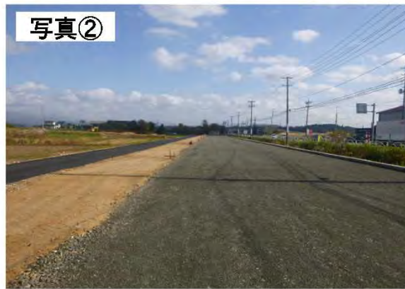
写真② ▲道路改良工事の施工状況 (R1.11撮影)
