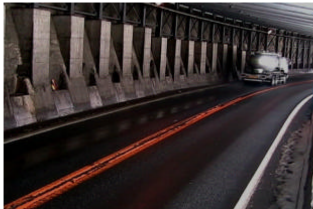
< 設置前の状況 >
