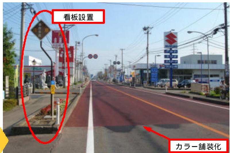
対策後の状況（寒河江 酒田方面）
