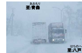
【写真1】冬期幅員減少状況
