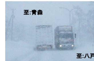
▲【写真1】 冬期幅員減少状況
