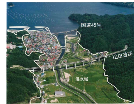
▲ 津波を考慮して整備された山田道路 (H14.8.2開通)
