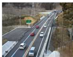
津波による被害がなかった三陸縦貫自動車道
