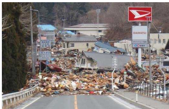
▲ ガレキ堆積で寸断された国道45号 (宮古市)
