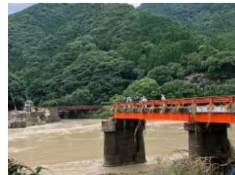
熊本県道 深水橋 令和2年7月豪雨 3ヶ月以上の通行止め
