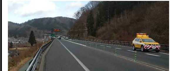
▲台風19号による被災はなく通常利用ができた普代道路
