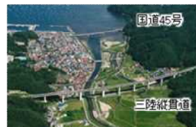
津波を考慮して高台に計画された三陸縦貫自動車道
