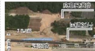
広島呉道路・国道31号の被害状況
