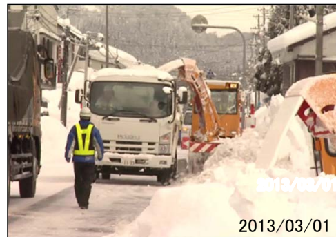
写真1 運搬排雪状況
