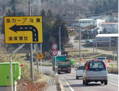
写真3 現道の線形不良箇所（R=75m）
