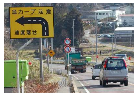
写真2 現道の線形不良箇所
