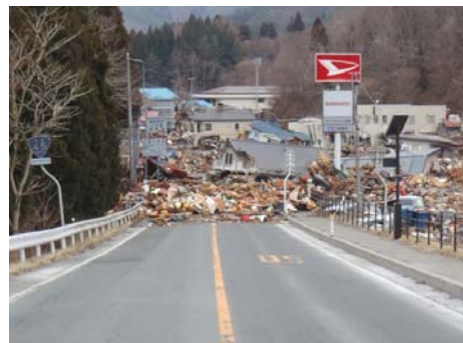
図2 寸断された国道45号 (宮古市田老町 国道45号)
