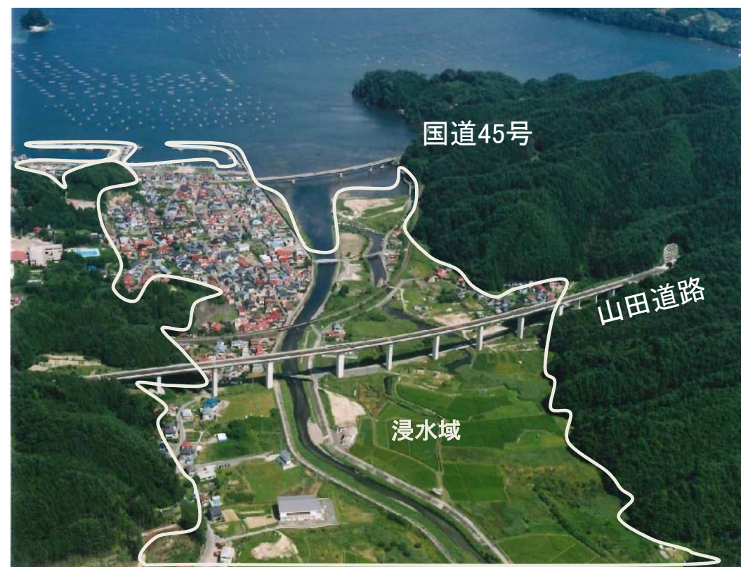
三陸縦貫道(山田道路)
