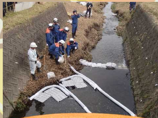
側溝等における油回収、オイルフェンスの組立・設置作業手順の確認
