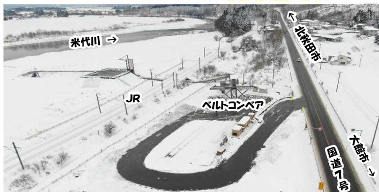
大館市大巻地区河道掘削で使用するベルトコンベアが1月5日より稼働しました。通常、掘削した土砂はダンプトラック等の車両で運搬しますが、重量制限で通行不可能な区間があるためこのベルトコンベアで運搬することとしたものです。
