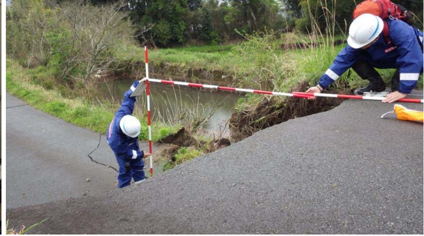
乙姫川断層部計測
