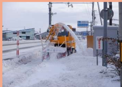
▲ 歩道除雪(国道7号)
