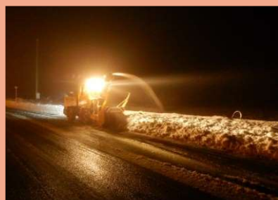
▲ 拡幅除雪(秋田道)
