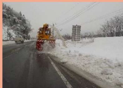
▲ 拡幅除雪(国道7号)
