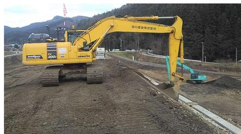
③ICTバックホウで法面の締め固めと表面の仕上げをします。
