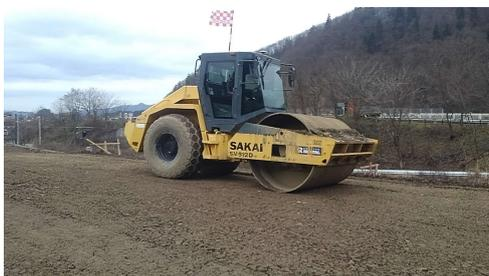
②敷きならした盛土材をICTローラーで締め固めます。
