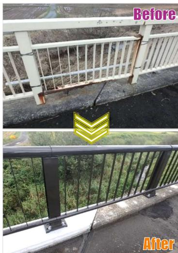
高欄…転落防止の手すり。腐食し老朽化した高欄を撤去して、新しい高欄に交換。
