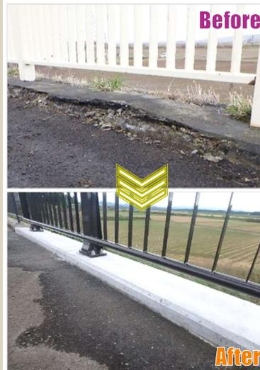
地覆…高欄の基礎部分。コンクリートが割れている部分を補修。
