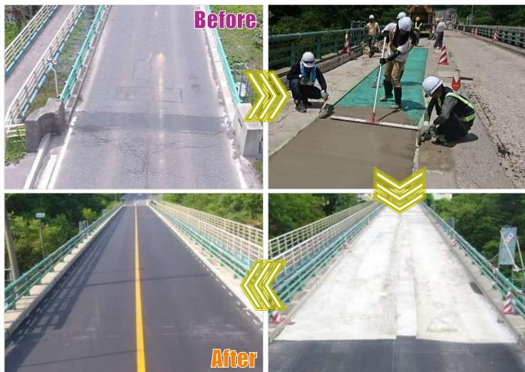
床版…橋のアスファルト下のコンクリート部分のこと。古くなったコンクリートを部分的に剥がして新しいコンクリートを施工。
