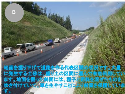
B 地面を掘り下げて道路を作る代表区間の状況です。大量に発生する土砂は、崖土の区間に溜んで有効利用しています。地面を掘った側面には、種子と肥料を混ぜたものを吹き付けている。草を生やすことにより斜面を保護しています。
