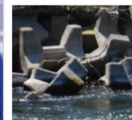
消波根固めブロックにはいろいろな形があります。 川岸が削られるのを防ぐはたらきがあります。
