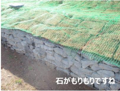
堤防の下部分に大きめの石をパズルのようにすきまなく埋め込み、金網で固定します。その上から土をかぶせて完成です。
