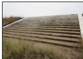
〈低水護岸（船着場）〉
