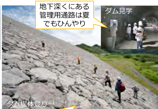
ダム堤体を登れるのはロックフィルダム構造である森吉山ダムならではの！※1
