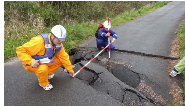
乙姫川計測作業状況
