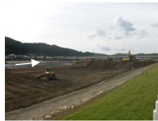
河道掘削状況 (能代市ニツ井地区)
