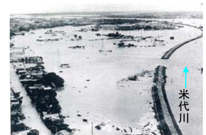
能代市中川原地区の浸水状況
