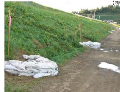
あままい 天内地区 堤防裏法面の漏水被害状況（H19.9洪水）
