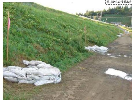
天内地区 堤防裏法面の漏水被害状況
