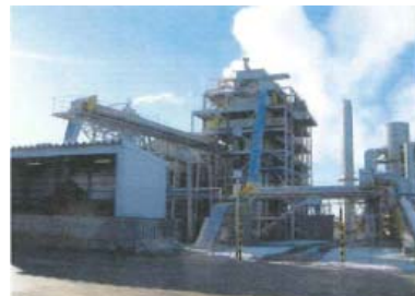
バイオマス発電施設
