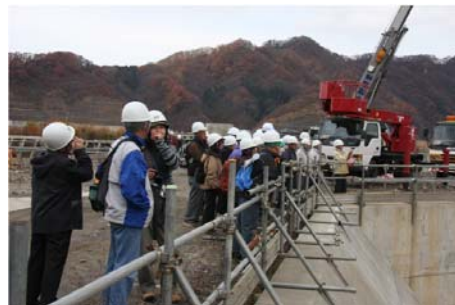
機械設備関係の工事状況を視察した 平成20年11月14日
