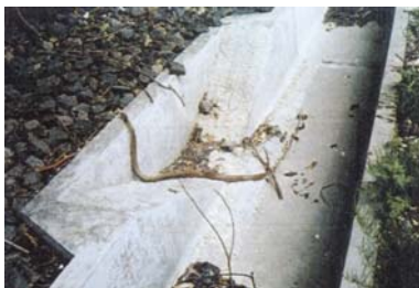
落下した小動物がはい上がれるようにスロープを設置
