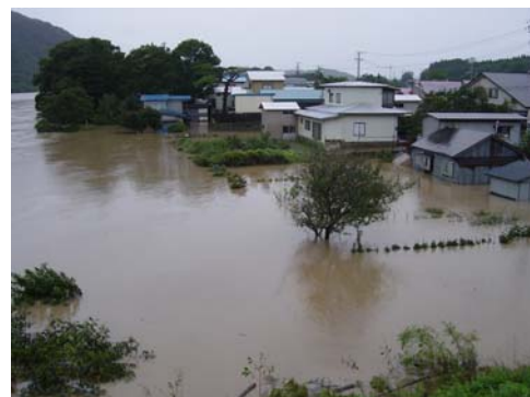
平成19年9月洪水による被災状況 (能代市二ツ井町麻生)
