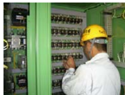
機側操作盤の点検状況
