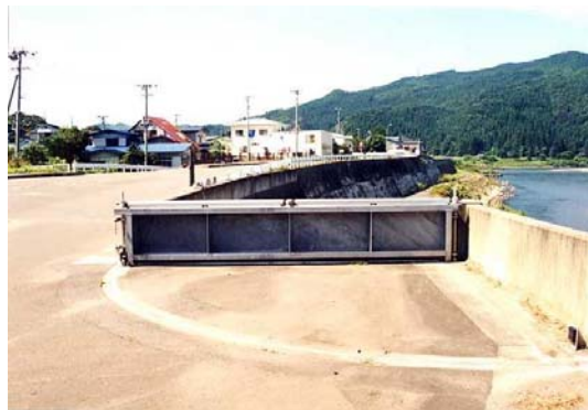
河川管理施設 陸閘 (仁鮎第3陸閘)
