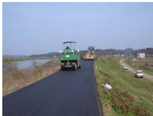
堤防天端舗装状況
