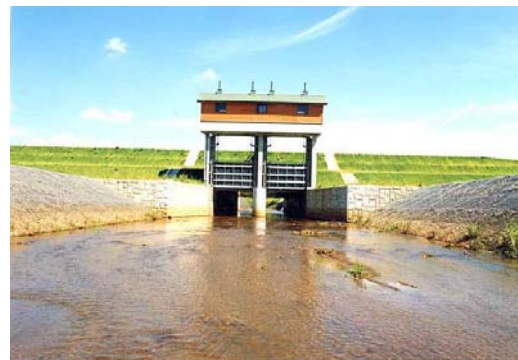
河川管理施設 水門 (前山川水門)
