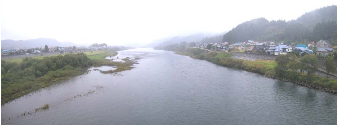
平成 15 年 9 月 25 日 流量 123m 3 /s (平水流量程度)
