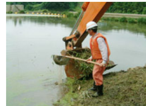
貯水池内の流木及び土砂撤去
