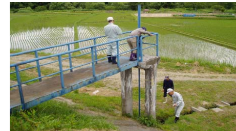
占有者との施設合同点検
