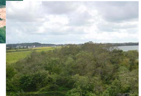
樹木繁茂状況(10.0k付近)
