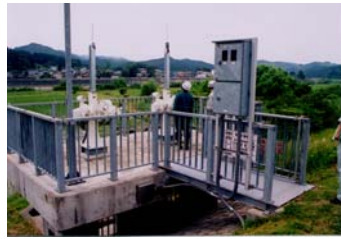
河川管理施設の点検
