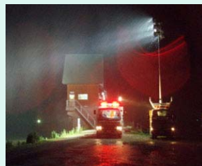
前山川水門（北秋田市）での排水ポンプ車による内水排除作業状況
