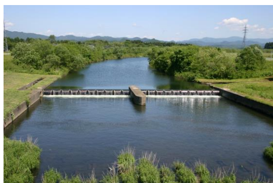
河川管理施設 堰 (小猿部川可動堰)
