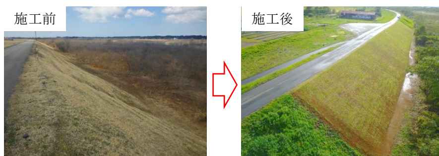
堤防法面の補修状況
