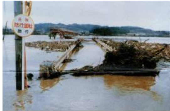
昭和 55 年 4 月融雪洪水による被災状況 (能代市二ツ井町 下田平地区)
