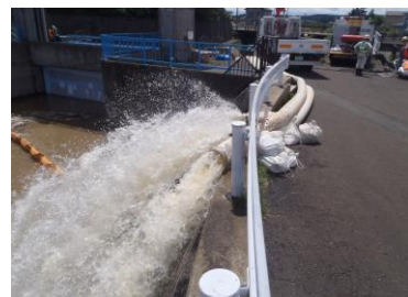
排水ポンプ車の出動状況
