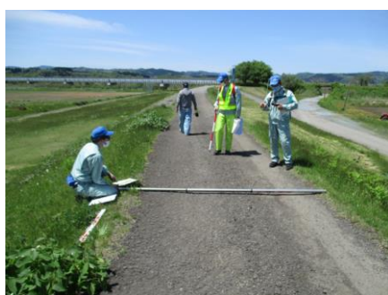
堤防点検の様子
