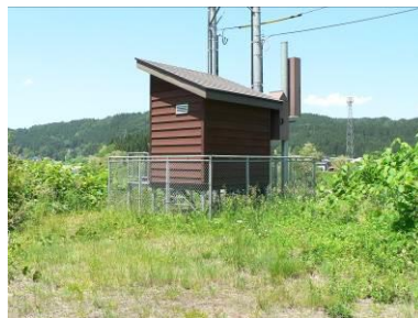
森吉山ダム 警報施設
