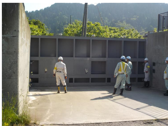
河川管理施設の点検（陸閘）
