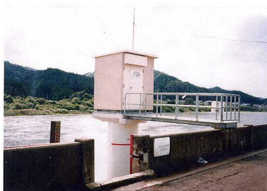
二ツ井水位観測所
