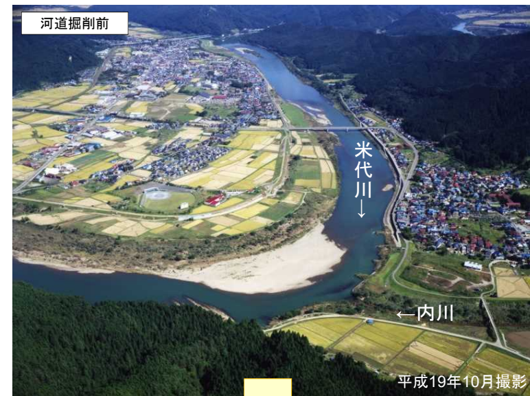
河道掘削状況【能代市ニツ井地区】
