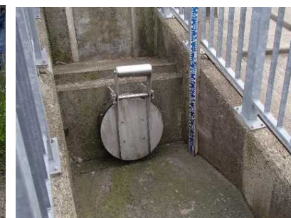
▲中川原排水樋管
