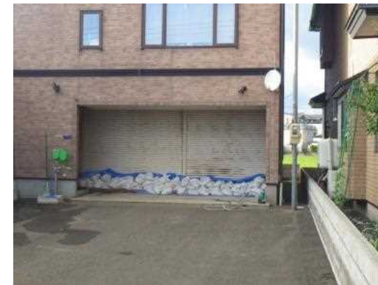
土のうやシートで浸水防止対策を実施した例
