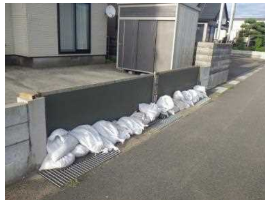
土のうやシートで浸水防止対策を実施した例
