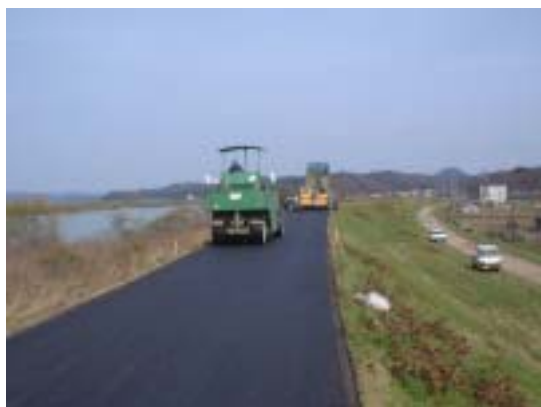
堤防天端舗装状況
