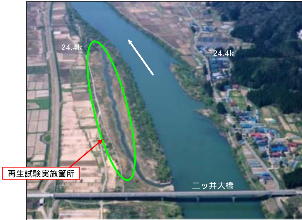
河畔林の再生実施状況（ニッ井町） 平成 15 年 5 月
