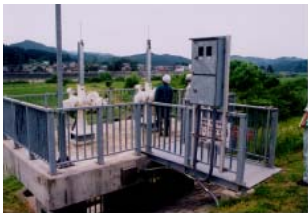
河川管理施設の点検
