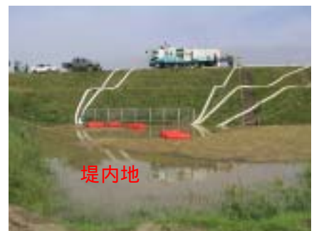
排水ポンプ車稼働状況
