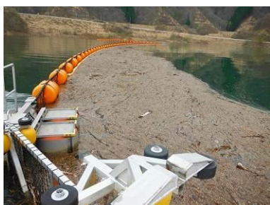
森吉山ダム 流木止施設
