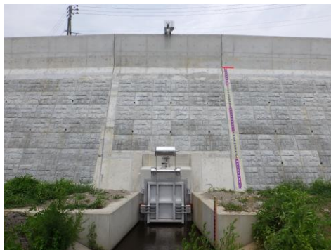
河川管理施設 樋門・樋管 (川口排水樋門)
