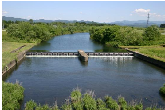
河川管理施設 堰 (小猿部川可動堰)
