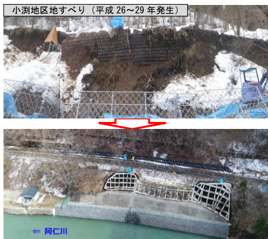
小湊地区地すべり防止施設 (平成 30 年完成 事業主体：秋田県)
