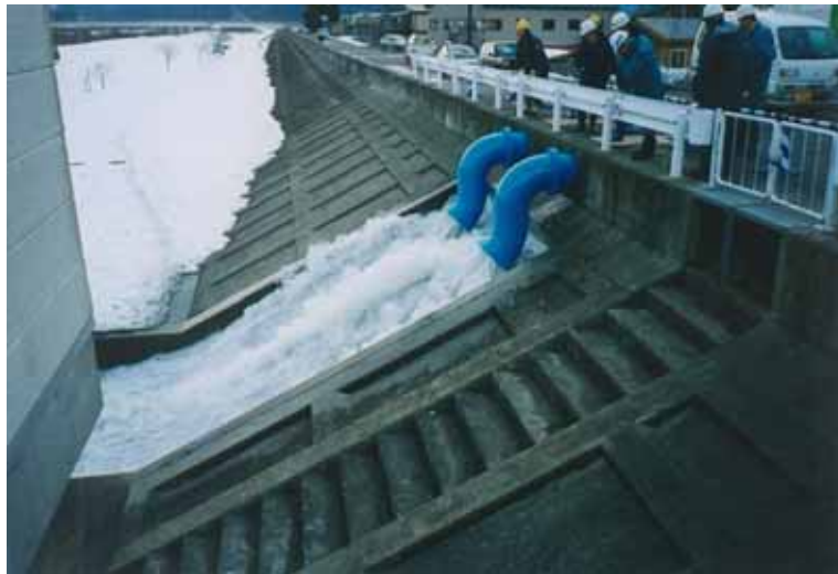
救急内水ポンプによる排除状況（二ツ井町薄井地区）
