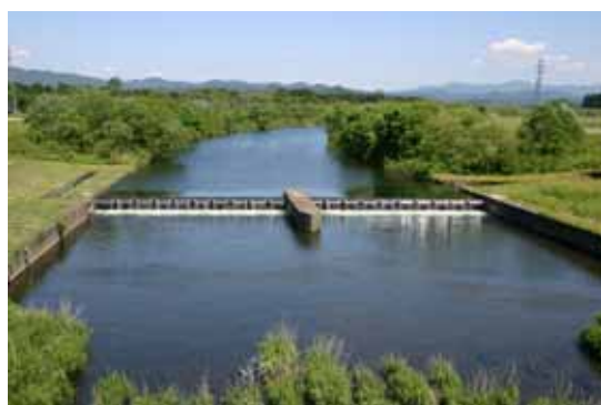
河川管理施設 堰（小猿部川可動堰）
