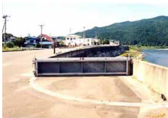
河川管理施設 陸閘（仁鮎第3陸閘）
