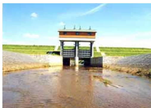
河川管理施設 水門（前山川水門）
