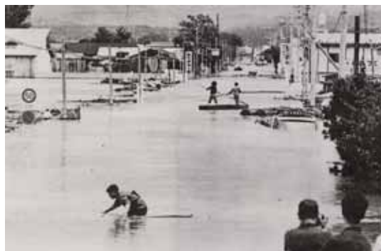
S47.7 洪水による被災状況 (能代市又右エ門橋付近)
