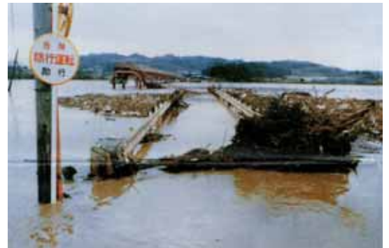
S55.4 融雪洪水による被災状況 (二ツ井町下田平)
