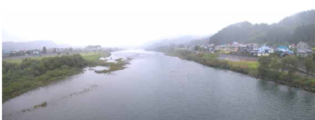
平成15年9月25日 流量123 m 3 /s (平水流量程度)
